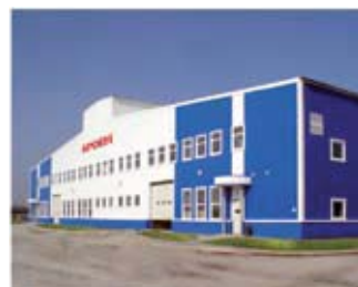
Производственный комплекс BROEN в Коломне
